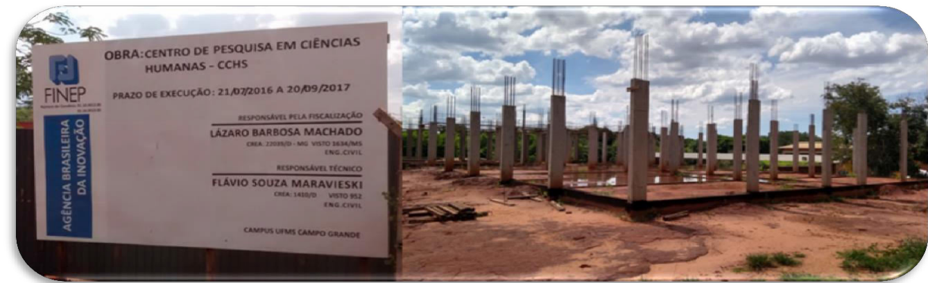
Figura IV Obra: Centro de Pesquisa em Ciências Humanas, Local: Unidade X (Próximo aos prédios dos cursos de Música e da Química) (foto de 30/11/2016)
