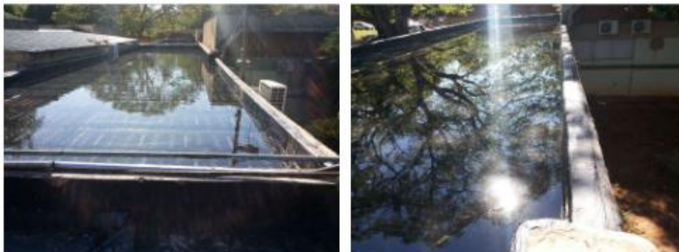
Imagem 12 – Teste de estanqueidade
