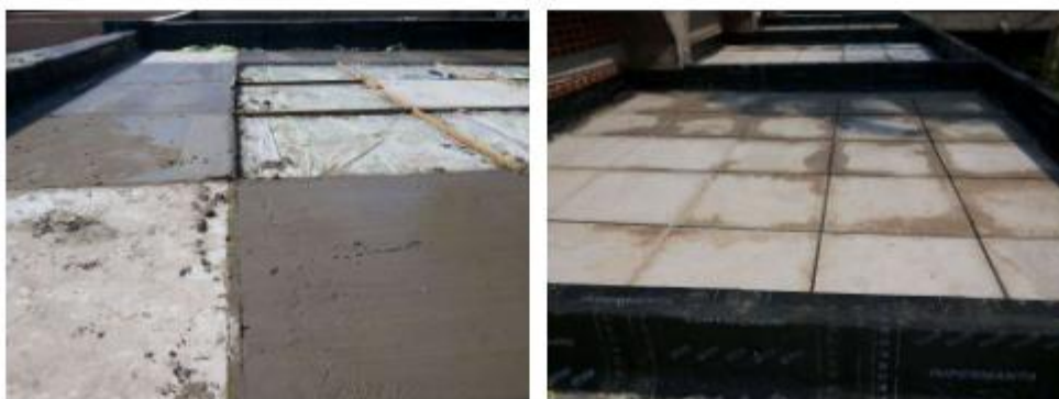
Imagem 14 – Argamassa de proteção mecânica
