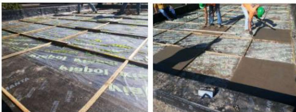
Imagem 13 – Camada separadora com filme de polietileno
