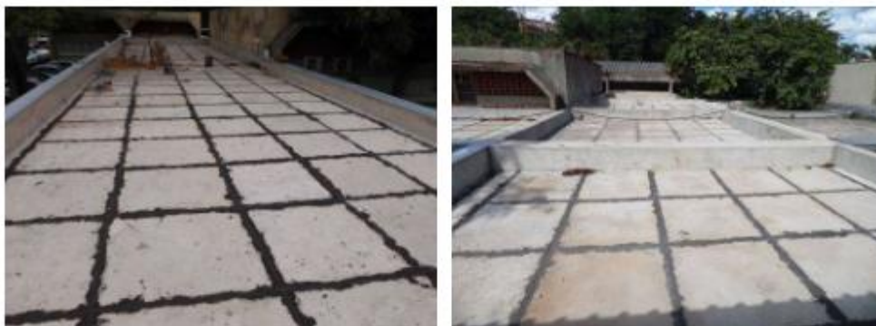
Imagem 16 – Aplicação de argamassa betuminosa em junta de dilatação
