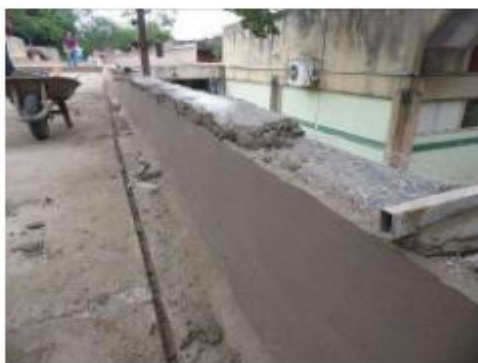
Imagem 15 – Proteção mecânica em trechos verticais
